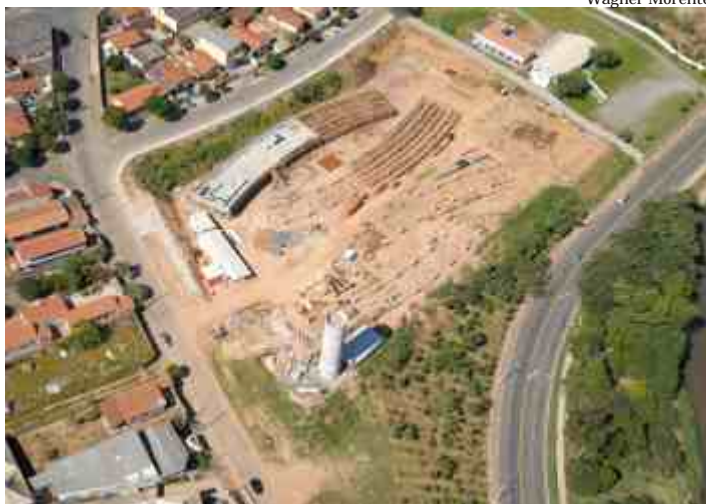
Vista aérea do início da obra, em maio. Terreno foi doado pela Prefeitura Municipal
